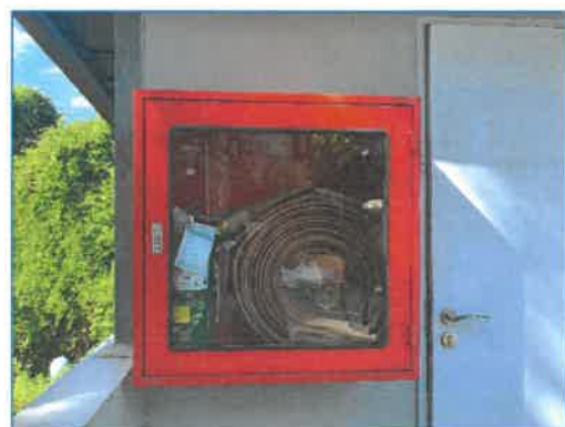
ระบบแจ้งเตือนอัคคีภัยและป้องกันอัคคีภัยภายในโครงการ
