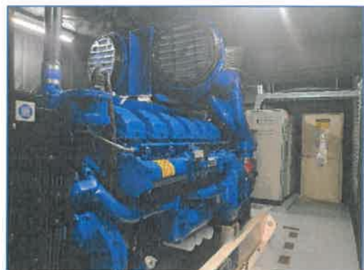
ภาพถ่ายที่ 2.2-12(1) เครื่องกำเนิดไฟฟ้าสำรอง
