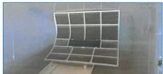
ภาพถ่ายที่ 2.2-23 การทำความสะอาดเครื่องปรับอากาศ
