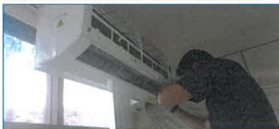
ภาพถ่ายที่ 2.2-23 การทำความสะอาดเครื่องปรับอากาศ
